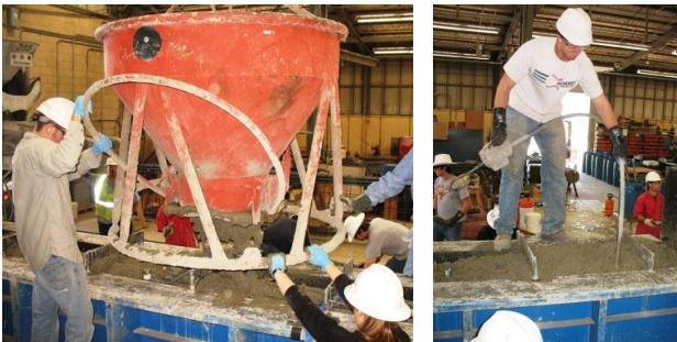
(d) Place concrete
