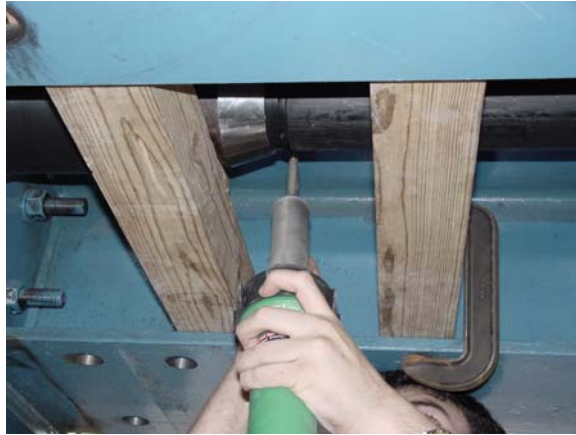
Figure 3-27: PE Welding
