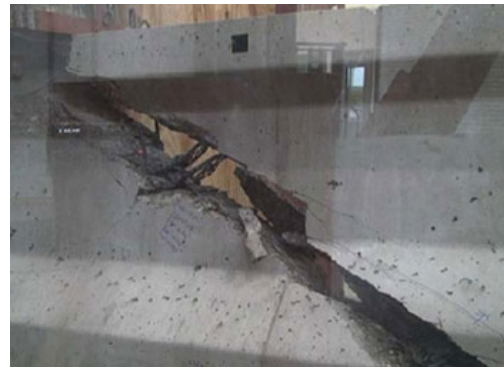
(d) Shear tension failure
