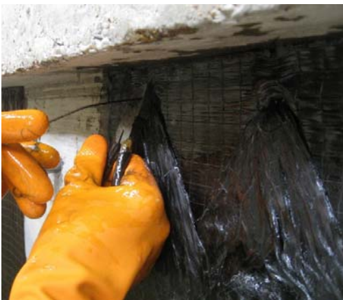
13) Cut the rebar tie
