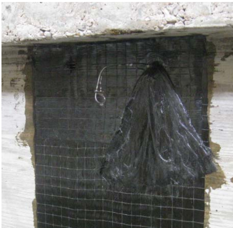
11) Fan out the CFRP anchor
