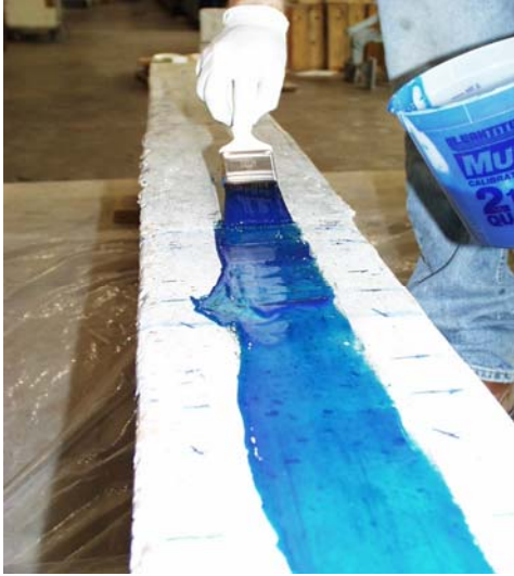
Figure 4.7.a: Apply epoxy resin.
