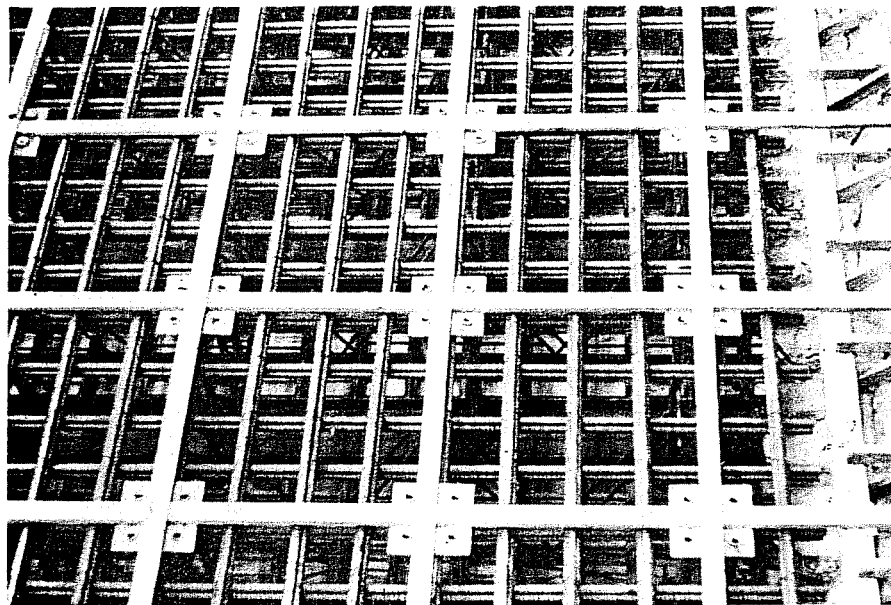
Fig. 4.4 Conduit alignment framework
