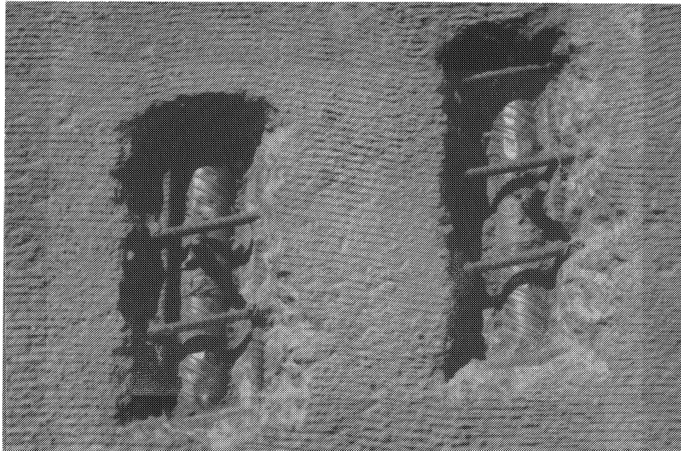
Fig. 3.4 Blockouts to conduit
