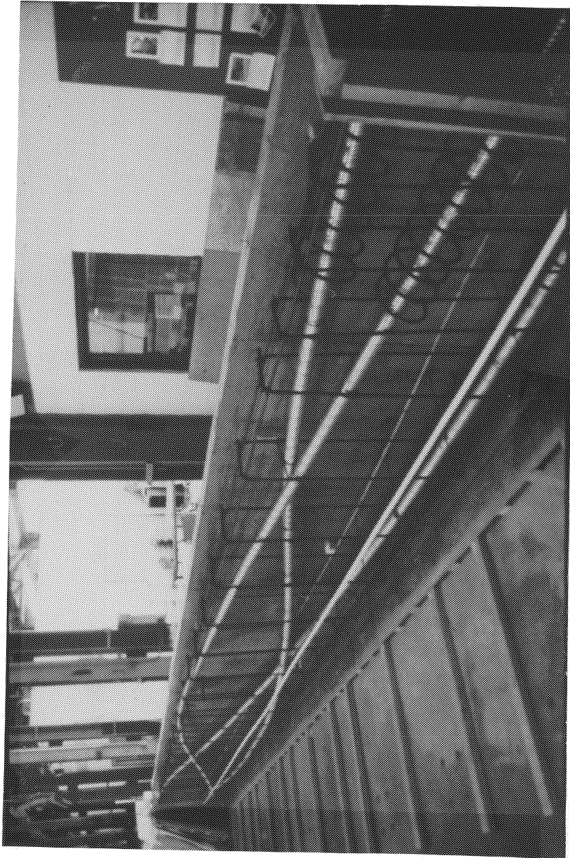
Fig. 2.10b Conduit placement 40 to 80 ft
