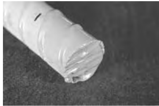
(d) Patched bar end (torch-cut) (IV).
