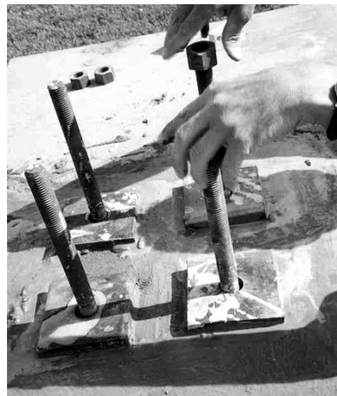
b. Cap Top Anchorage
