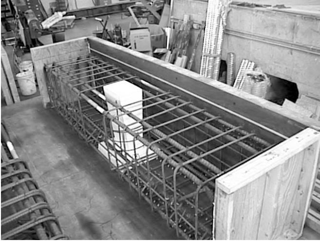
a. Rebar Cage
