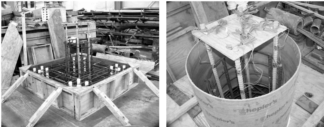
a. Rebar Cage
