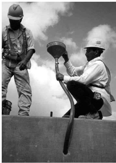
a. 2-in. Grout Tube
