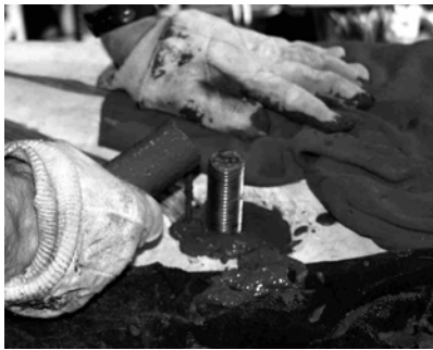
a. Topping Off Duct
