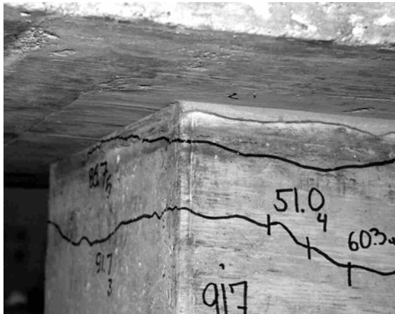
a. NE Side of Pile
