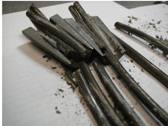
(d) Four Wire Fractures in Bottom Strand at Wedges
